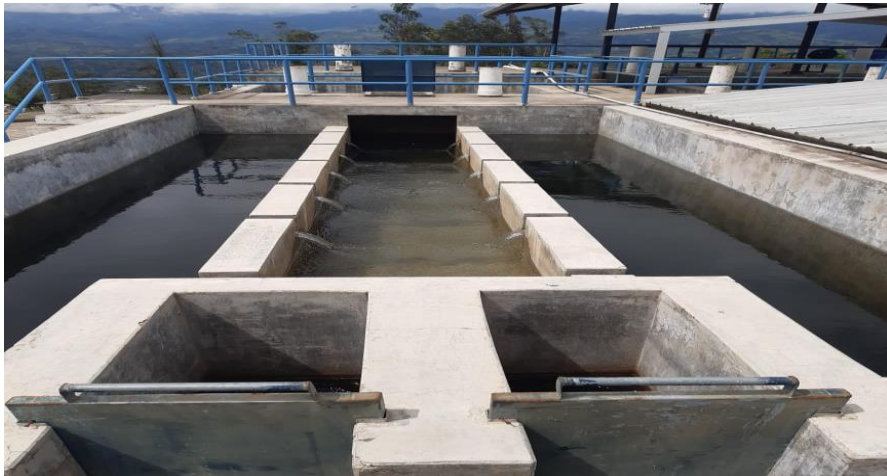
Figura 9 Proceso de Sedimentación
