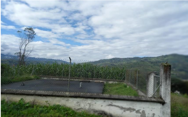
Figura 24 Tanque de reserva de 100m 3
