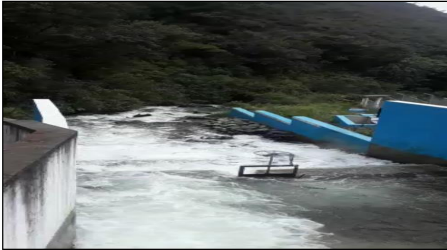
Figura 3 Captación de agua cruda del Rio Cañi
