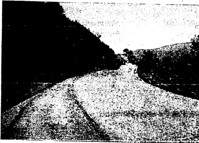
Fotografía No. 1: Vista de la calzada de la Vía parroquia Rivera – Parroquia Pindilig.
