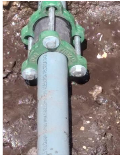
Instalación del riego
