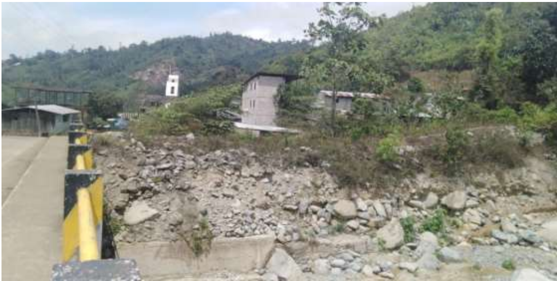
Foto 4 Reconstrucción del nuevo puente vía a Chazo Juan, 2021.
