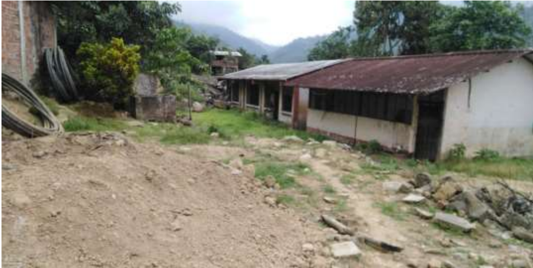
Foto 3 Centro educativo destruido por las inundaciones, 2021.
