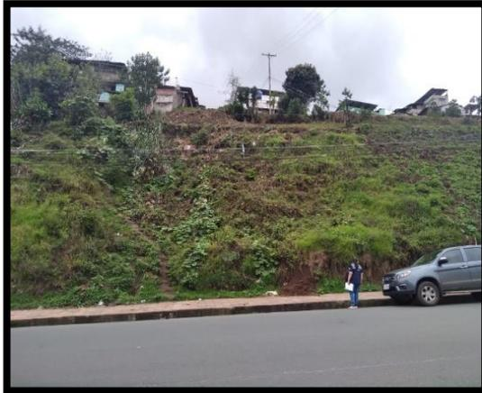
Se evidencia la presencia de varias viviendas a lo largo del talud, cabe mencionar es un talud de gran tamaño, además de evidenciar tubos de desagües generalmente de PVC de 4 pulgada que son utilizados para desfogues de aguas de las casas de los morados, el presente talud genera un gran peligro para los autos que circulan a diario en la vía principal.
