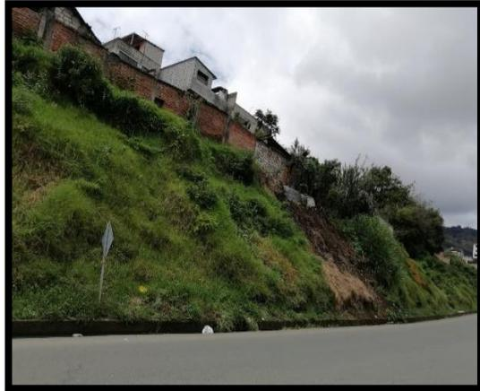
A lo largo del talud se puede observar la generación de grietas generadas debido a las fuertes precipitaciones, en la corona del talud existe la presencia de viviendas, además de evidenciar gran cantidad de malezas y no dar el tratamiento adecuado al mismo.
