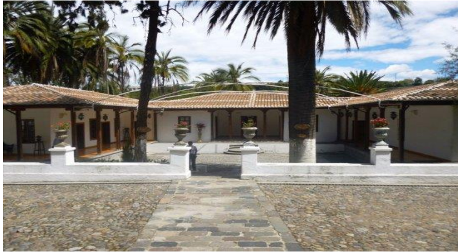
Fotografía 2. Estado actual de la construcción de la Quinta de Juan León Mera
