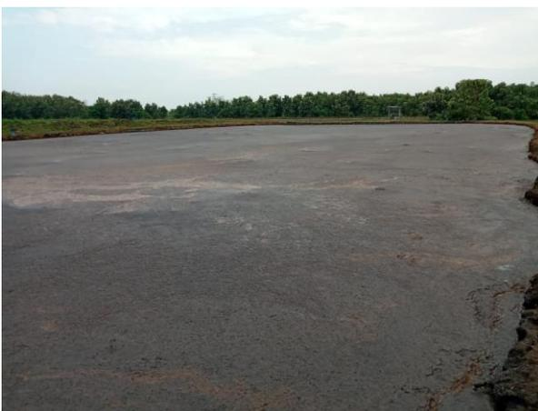
Una empresa extractora de mediana capacidad puede producir de 13 a 14  $\frac{m^3}{h}$  de efluente, que se descarga directamente a piscinas de oxidación mediante tuberías
