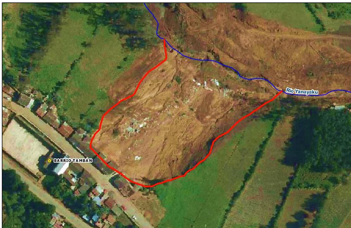
Figura 1. Deslizamiento en el año 2011 en el barrio Tambán
