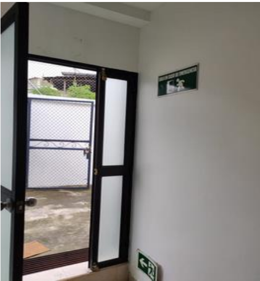
Imagen 11: Salida de emergencia planta baja
