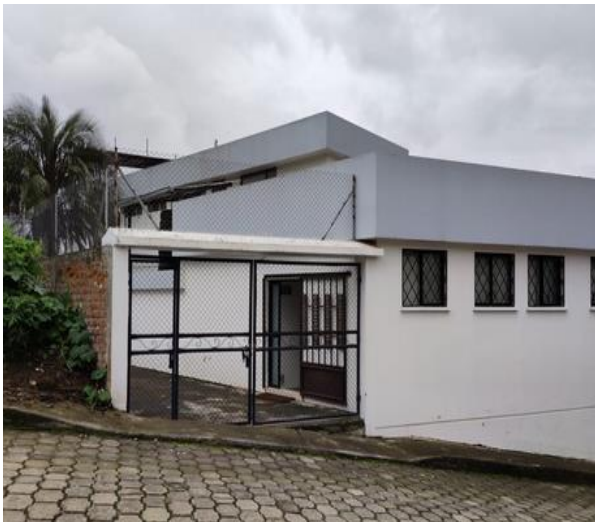
Imagen 3: Fachada lateral del CSBSM
