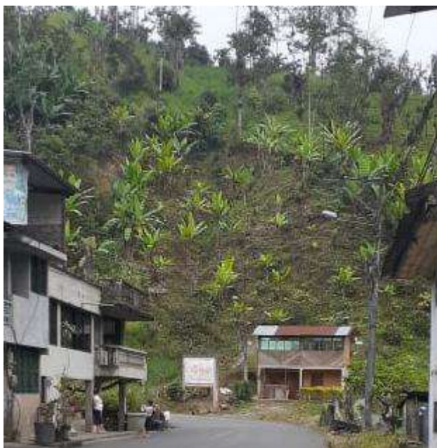
Vista panorámica del punto 01 deslizamiento en el sector Charquiyacu
