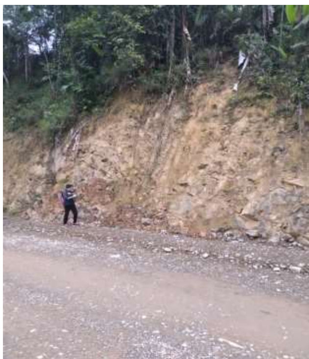
Descripción de la zona susceptible ante la amenaza deslizamiento en la Vía Charquiyacu a Pacana
