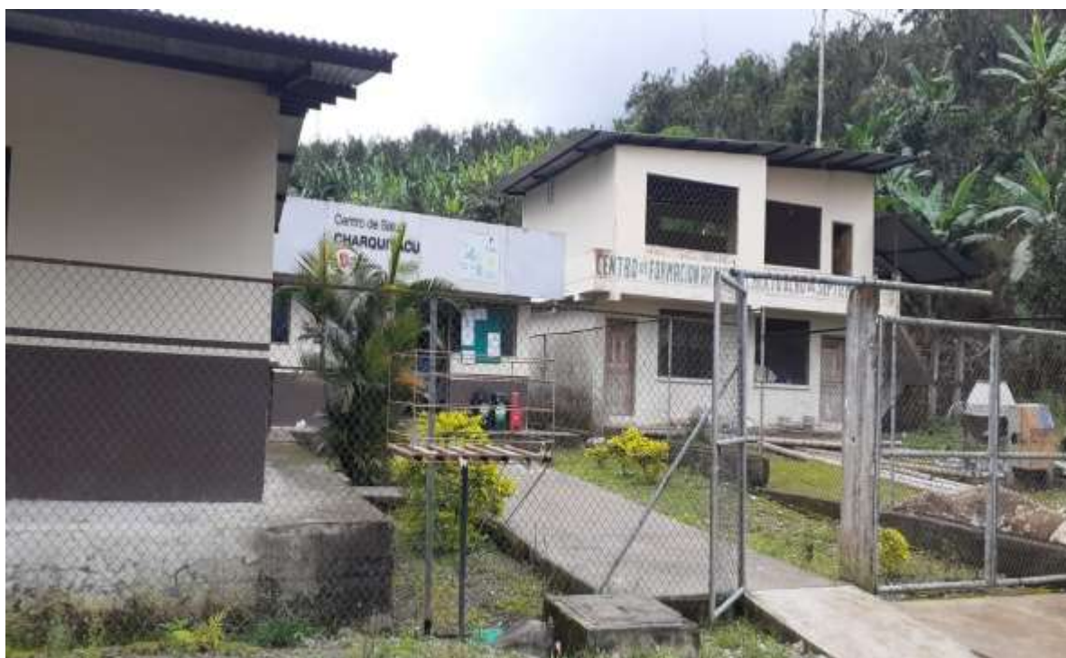
Centro de Salud del sector Charquiyacu
