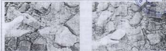
Fotos: Mezcla de concreto no embebe completamente a la piedra
