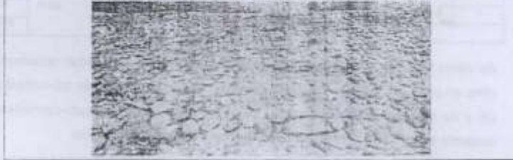
Fotos: Mezcla de concreto no embebe completamente a la piedra
