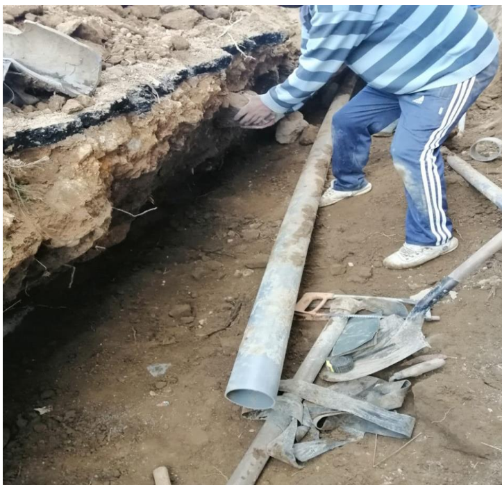
Foto 11: Mantenimiento de tuberías.
