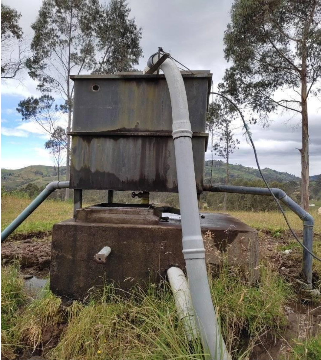
Foto 6: Tanque repartidor.
