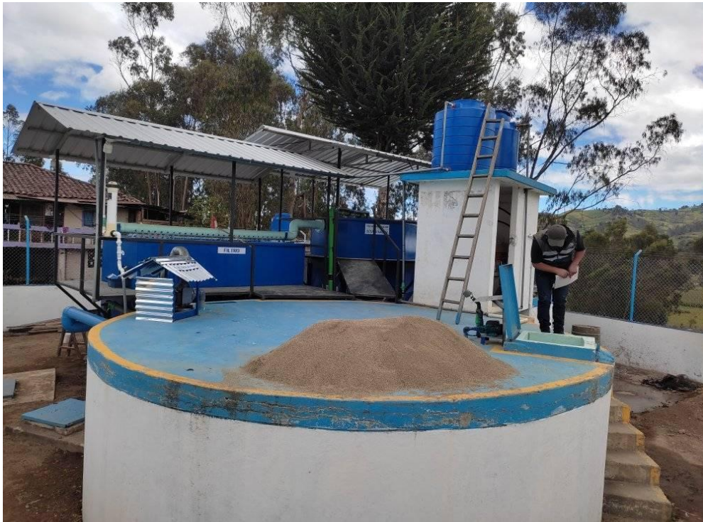
Foto 8: Observación y obtención de datos en la Planta de tratamiento.
