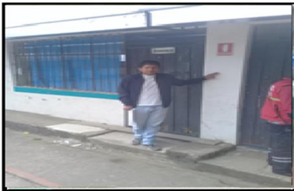
Foto 12 Equipos contra incendios ausentes en las unidades educativas
