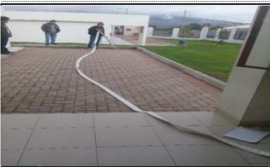
Foto 07 Manejo de bocas de incendio. Autor: Oscar, 2019
