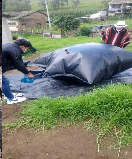
Fotografía 39.- Conexión de manguera de salía de gas
