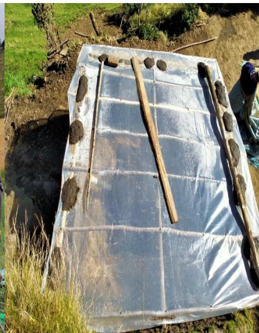
Fotografía 35.- Caseta lista para la instalación de biodigestor
