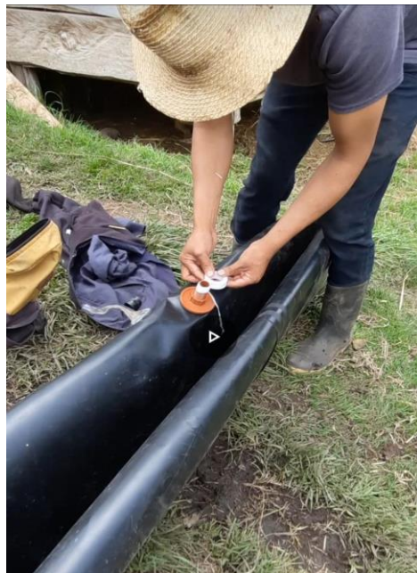
Fotografía 39.- Conexión de manguera de salía de gas
