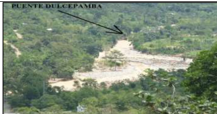
Foto 5. Vista panorámica del cauce del río aguas abajo del proyecto HidroTambo.
