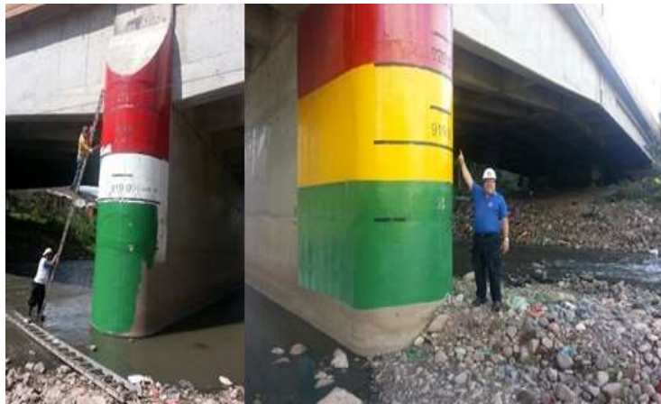
Figura 4. Escalas para registro de niveles del río.
