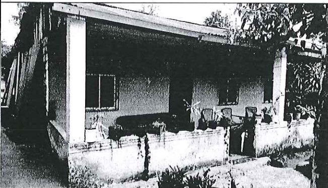
Fachada frontal de la vivienda del LOTE#1, vista en la dirección oeste-este .
