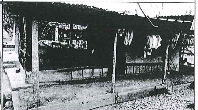
Fachada lateral de la bodega del LOTE#1, vista en la dirección sur-norte .
