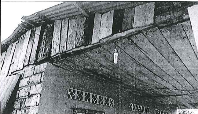
Cielo raso de la vivienda del LOTE#1, vista en la dirección norte-sur .
