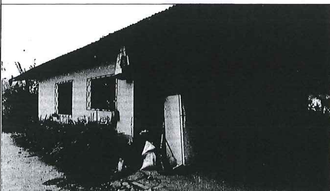
Fachada lateral de la vivienda del LOTE#2, vista en la dirección sur-norte .
