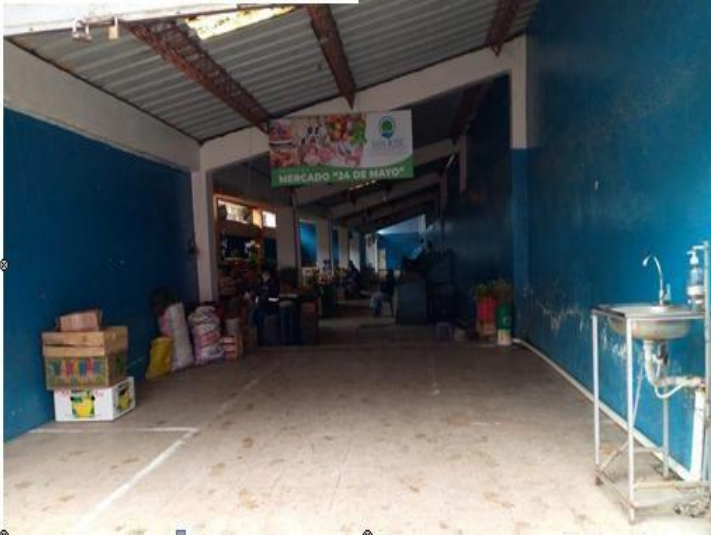
Foto 5. Inexistencia de las Señaléticas de Obligación EPP
