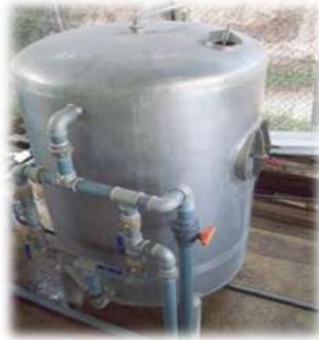
Este filtro de carbón activo se utiliza esencialmente para la expulsión de cloro y compuestos orgánicos que existen en el agua, el sistema de funcionamiento es el mismo que provee el filtro de arena, el que retiene los contaminantes al pasar el agua por este filtro compuesto específicamente de carbón activo.
