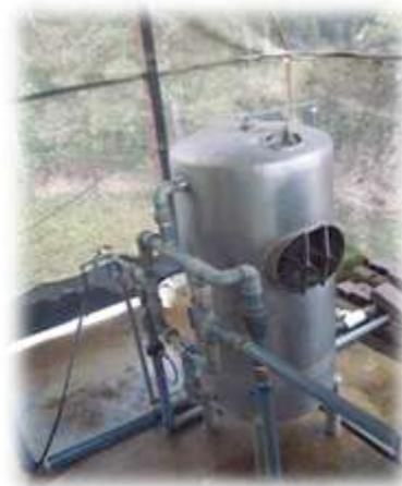
Es una herramienta que se utiliza para ayudar a la filtración de agua, en el mismo que se retienen partículas de hasta veinte micras de tamaño, las partículas en suspensión que lleva el agua son retenidas durante su paso a través del filtrante de arena lo que ayuda a liberar de impurezas al agua una vez que el filtro se haya cargado de impurezas, este se lo puede lavar y posteriormente dar su respectivo mantenimiento.
