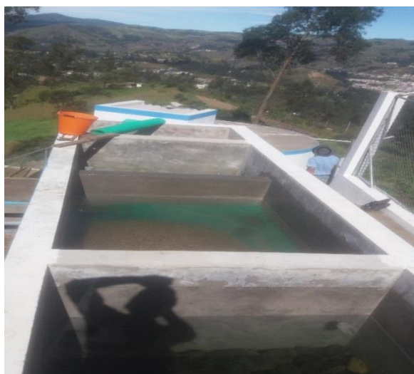
Interior del tanque de tratamiento
