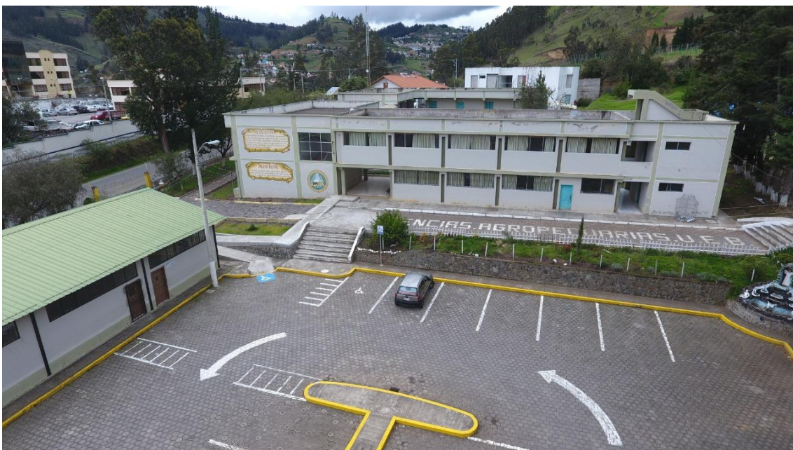
Parqueadero principal en El Lagucoto II
