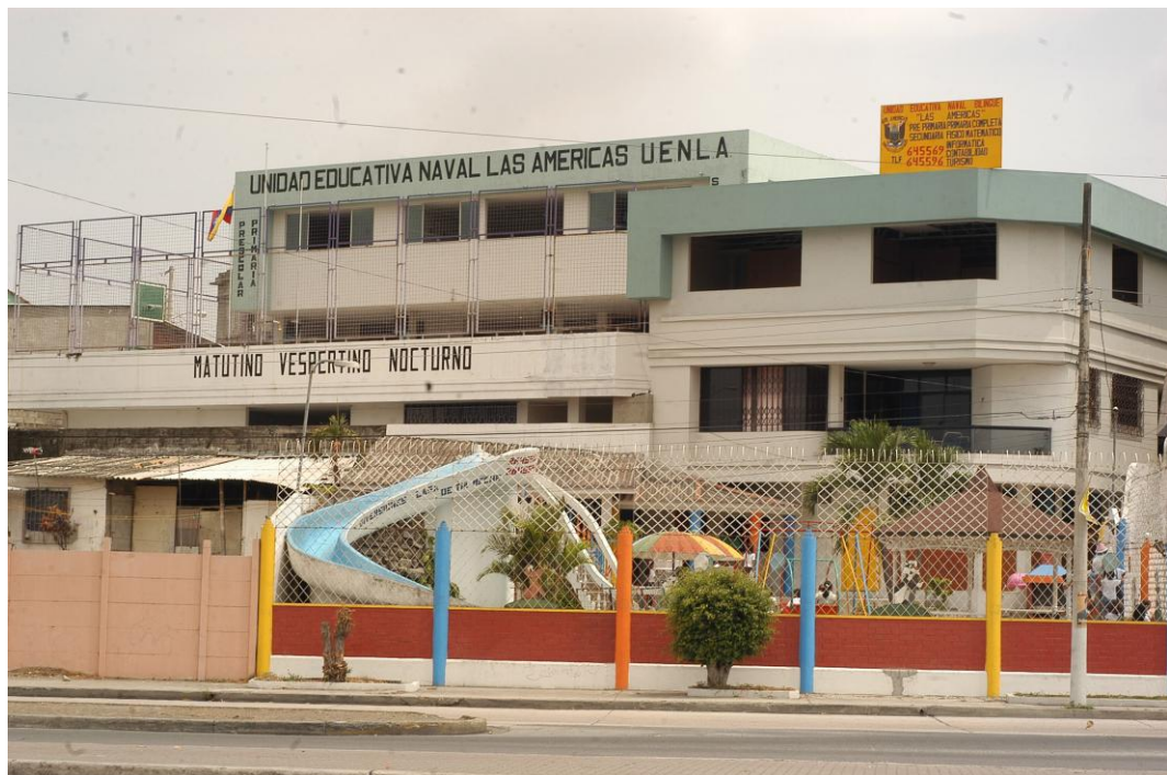
FOTO 4: EDIFICIO DE LA UNIDAD EDUCATIVA
