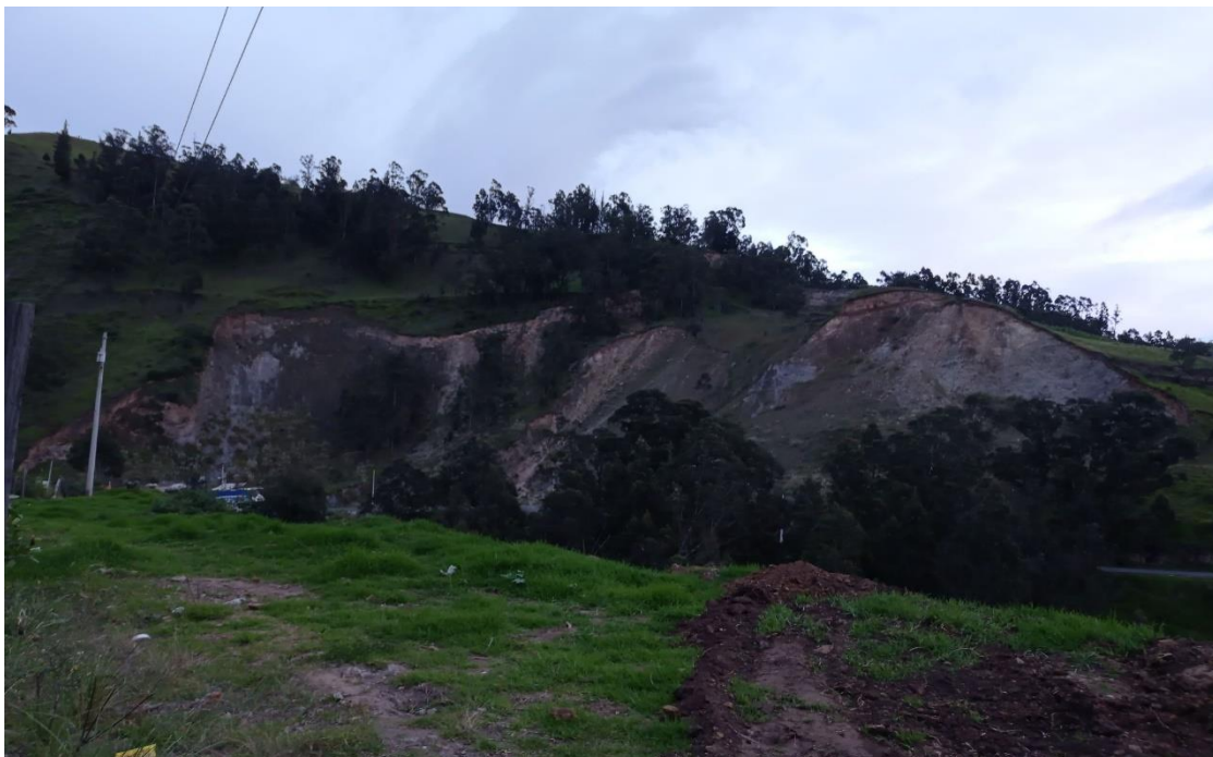
Fotografía 9: Existe desprendimiento de material en las laderas
