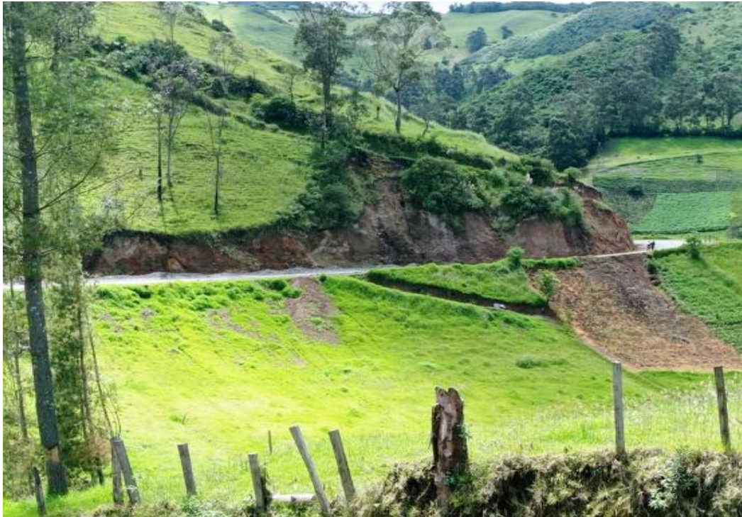
Fotografía N°4: Se observa que la vía se encuentra en laderas.
