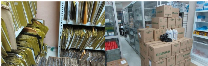
Figura 17 Las estanterías no se encuentran ancladas y sujetas una con otra.
