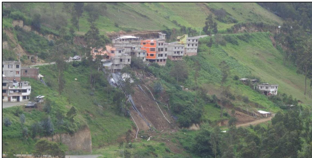
Fotografía 2: Asentamientos ubicados en zona de riesgo de deslizamientos
