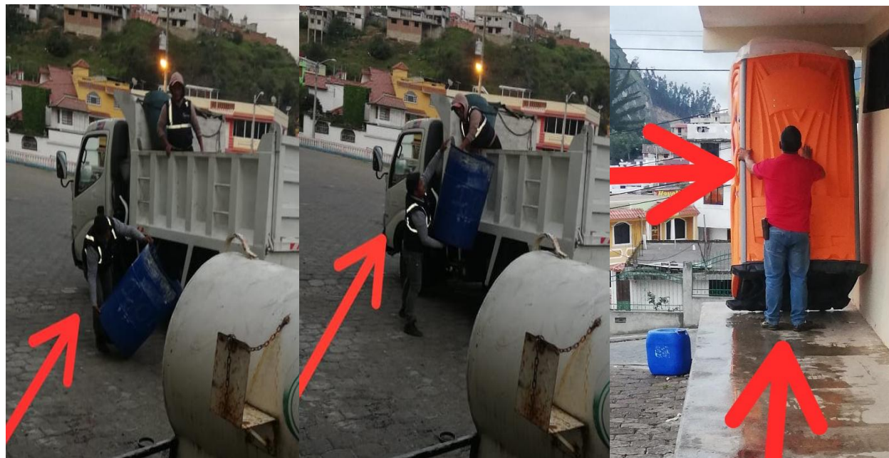
Figura 34: Trabajador con exceso de carga.
