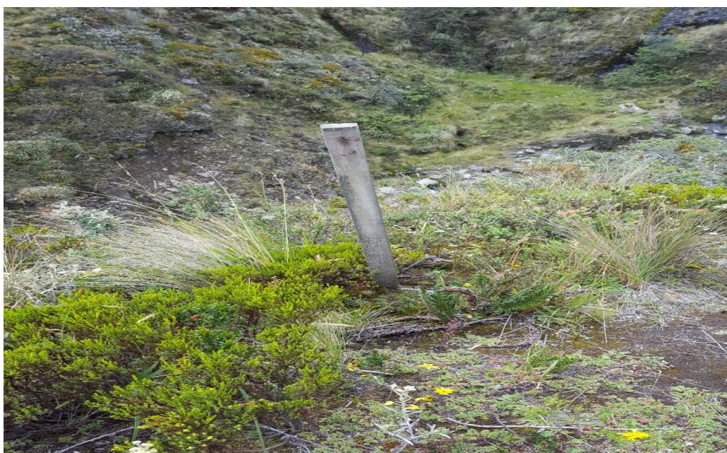
Detalle: Señal antigua deteriorada
