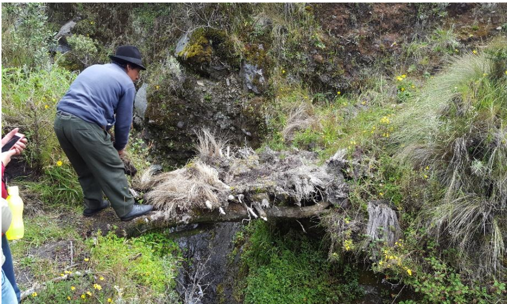
Detalle: Puente improvisado y deteriorado
