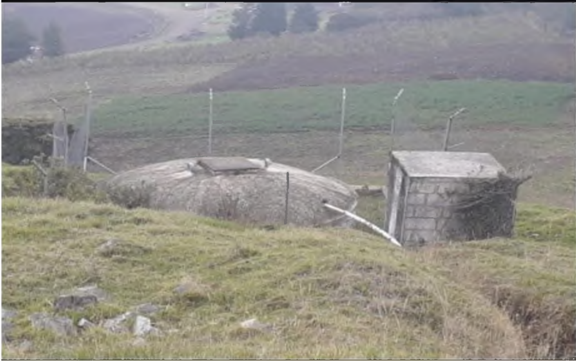
Fotografía 5. Tanque reservorio de agua que cuenta la comunidad
