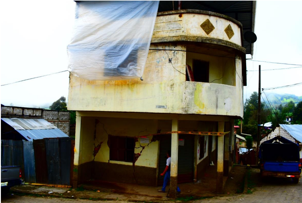
IMAGEN 24. Foto de la edificación sujeta a estudio mediante modelamiento estructural.
