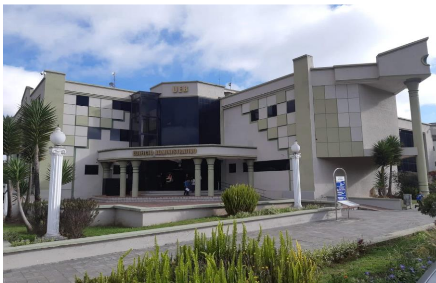
Figura 9: Edificio Administrativo de la U.E.B.
