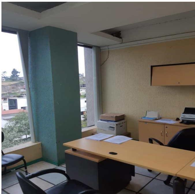
Figura 22: Fisura en Viga
