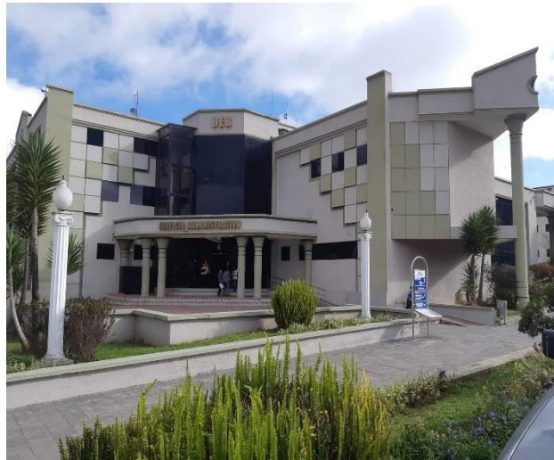
Figura 13: Edificio Administrativo de la U.E.B. (RECTORADO)
