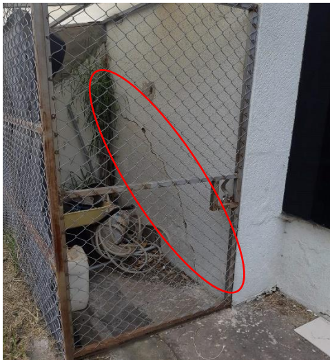
Figura 18: Fisura Exterior
