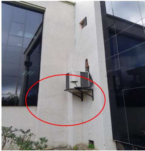
Figura 16: Fisuras Externas
