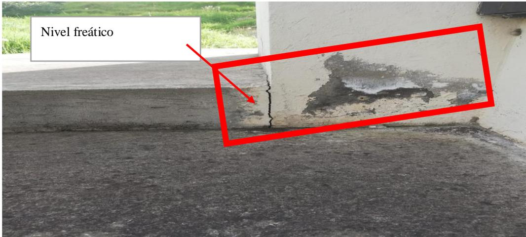
**Fotografía 8 :** Síntomas de las patologías estructurales en la pared fuera del edificio primera planta.
