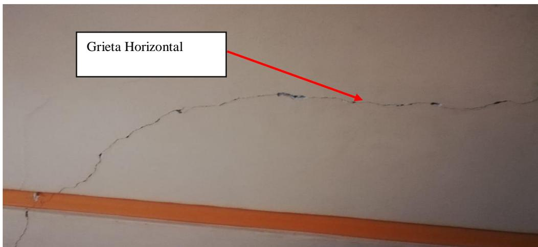
**Fotografía 5 :** Síntomas de las patologías estructurales en la pared primera planta.
