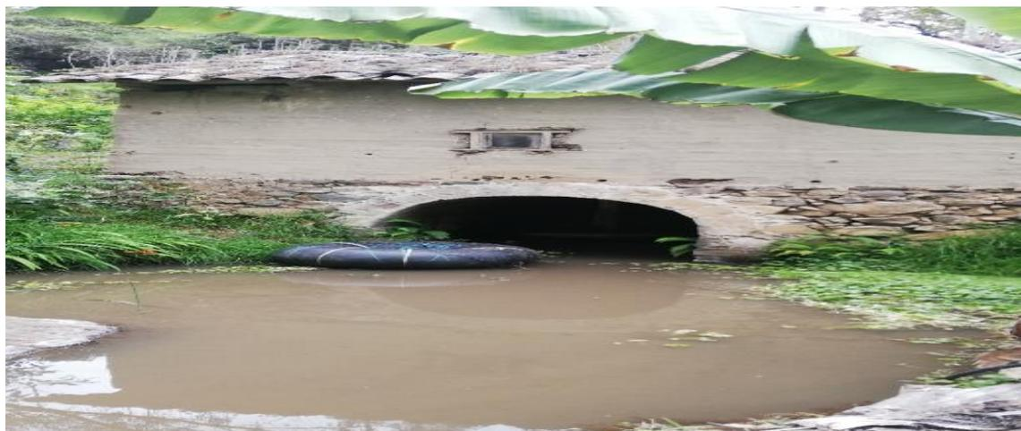
**Descripción de la fotografía:** Parte por donde sale el agua que era utilizado para el funcionamiento del molino
