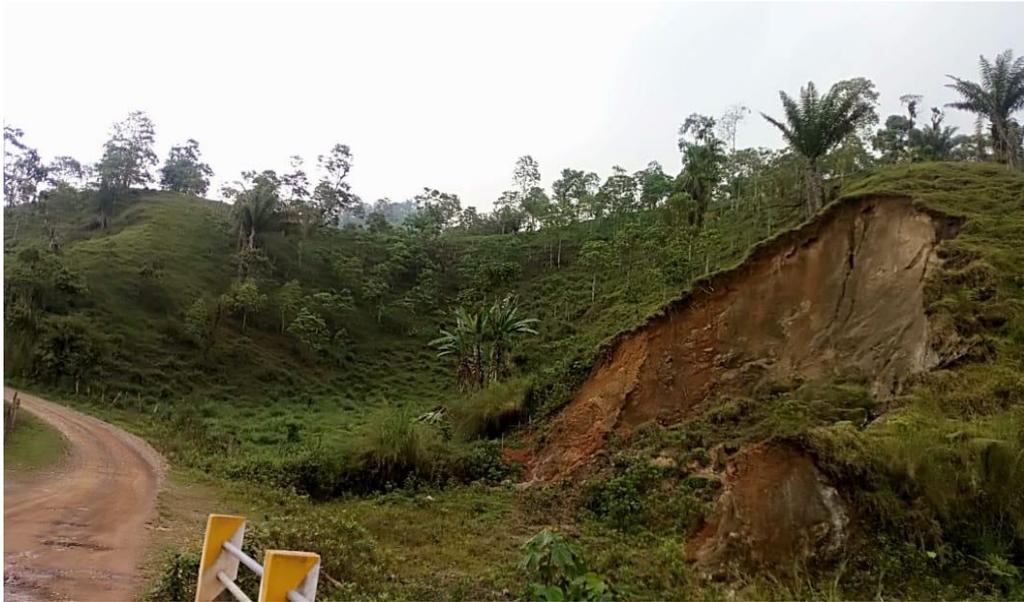
Fotografía N° 7: Zona de Deslizamiento en el tramo de la vía Mulidiahuán - Chazo Juan
