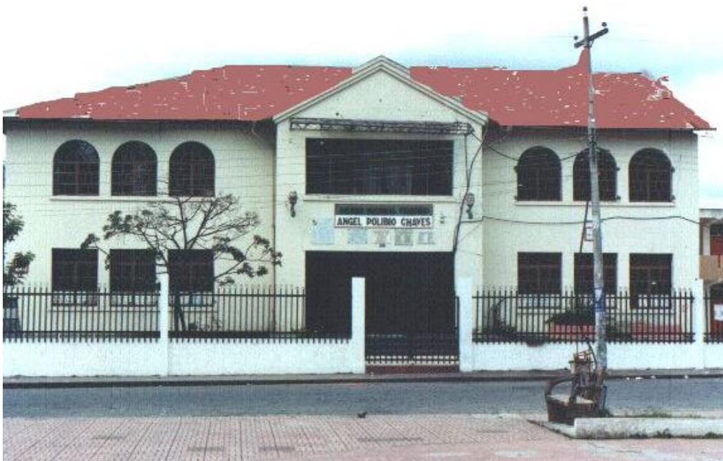
Fachada principal antigua de la Institución
