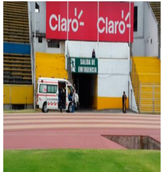
Salida de vehiculos de emergencia
