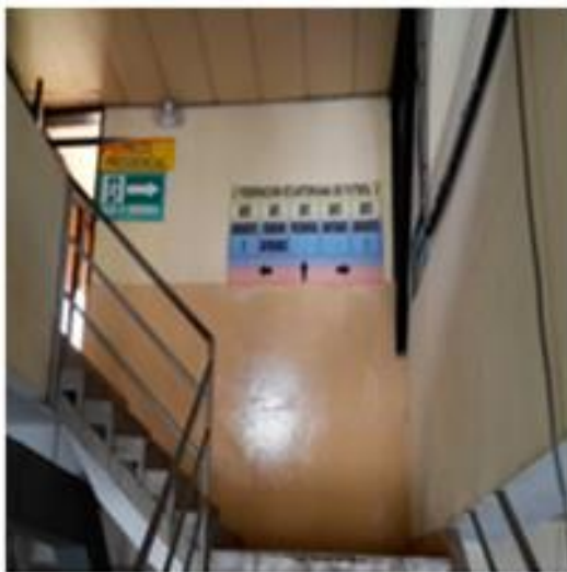
Salida de emergencia área de palcos
