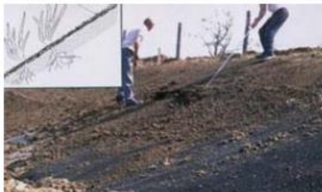
Fotografía 13. Esparcimiento de tierra sobre una geo manta para ayudar al crecimiento de la vegetación que protegerá al talud.
