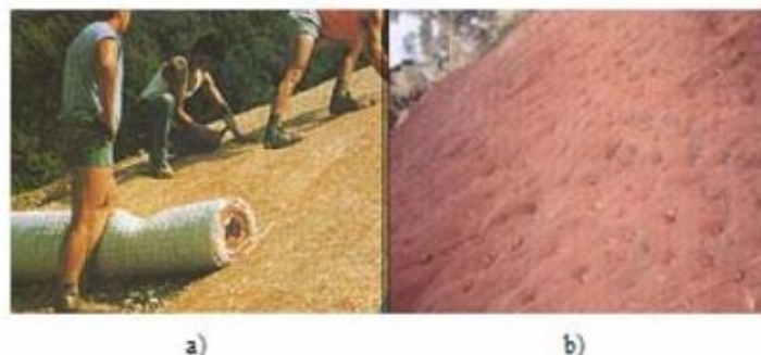
Fotografía 11. Instalación de biomantas.
