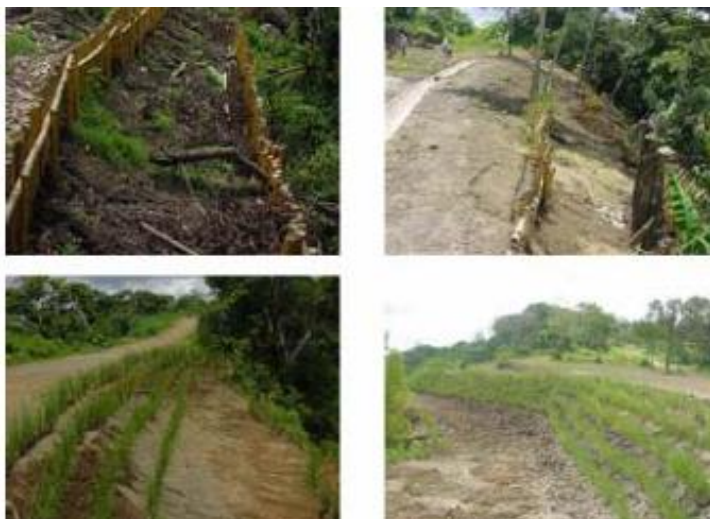
Fotografía 16. Ejemplo de utilización de barreras vivas para estabilizar taludes.
