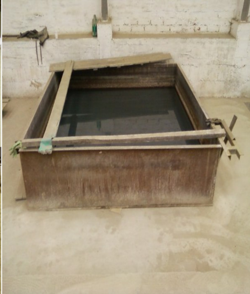
Tanque de agua
