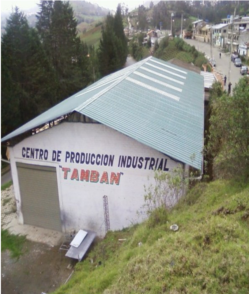
Vista área del Hangar Principal
