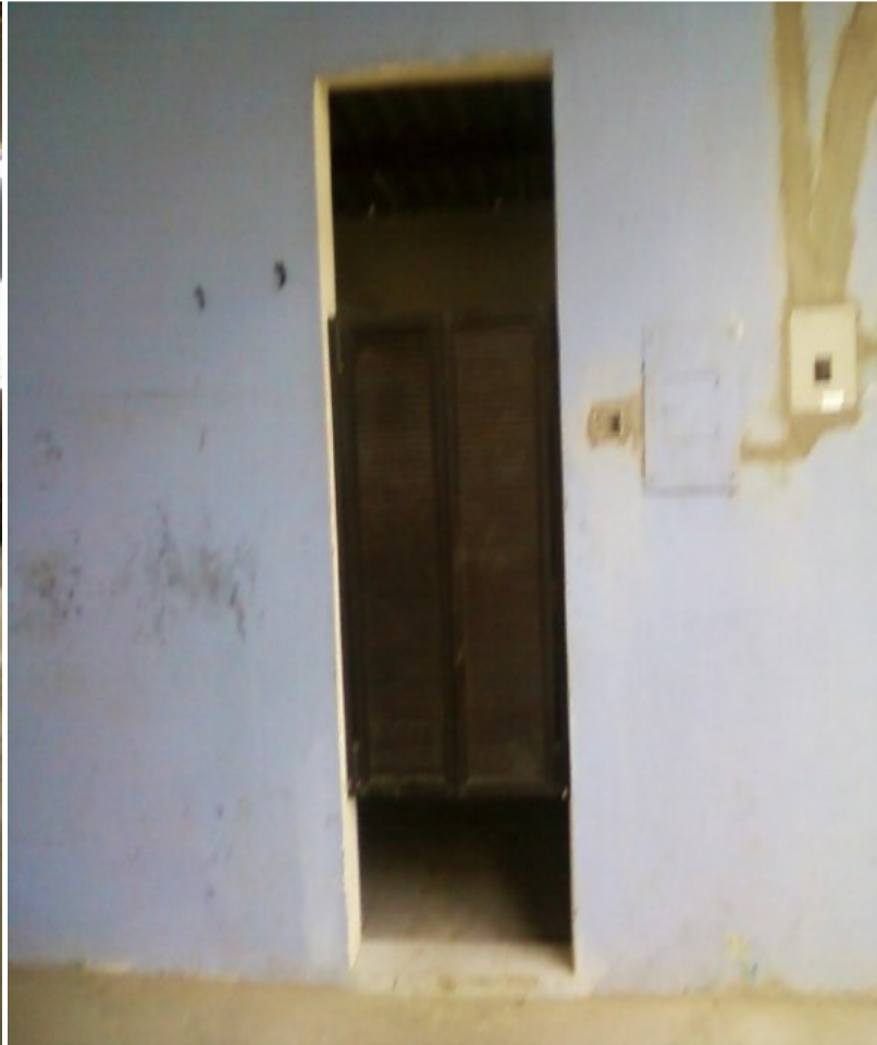
Entrada a los baños (Reparación)
