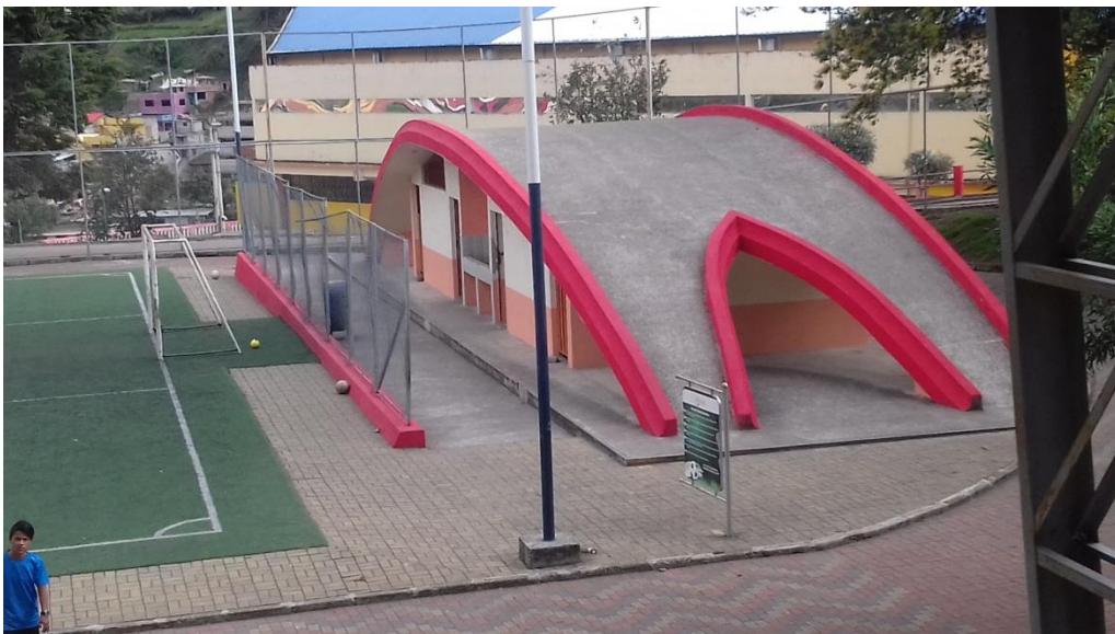
.Zonas recreativas y baterías Sanitarias.
