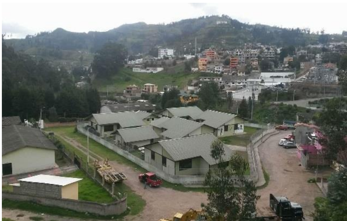
Acondicionamiento de viviendas para refugio en emergencia.
