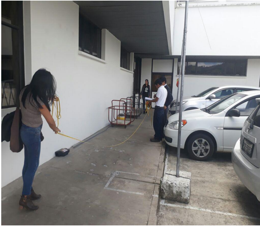
Fotografía 3 Levantamiento de Información estructural en el Hospital Básico del IESS.
