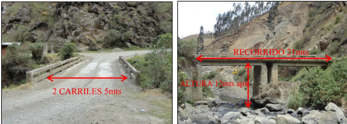
**Puente Sector el Socavón** (Sobre El Río Salinas); de poca circulación de vehículos, construcción muy antigua en piedra y cemento sin mantenimiento preventivo y en gran deterioro angosto, utilizado, en ocasiones para paso lateral sur, Vía que podría ser utilizada para desfogue hacia la parte sur y unirse a la panamericana; ubicado en:
