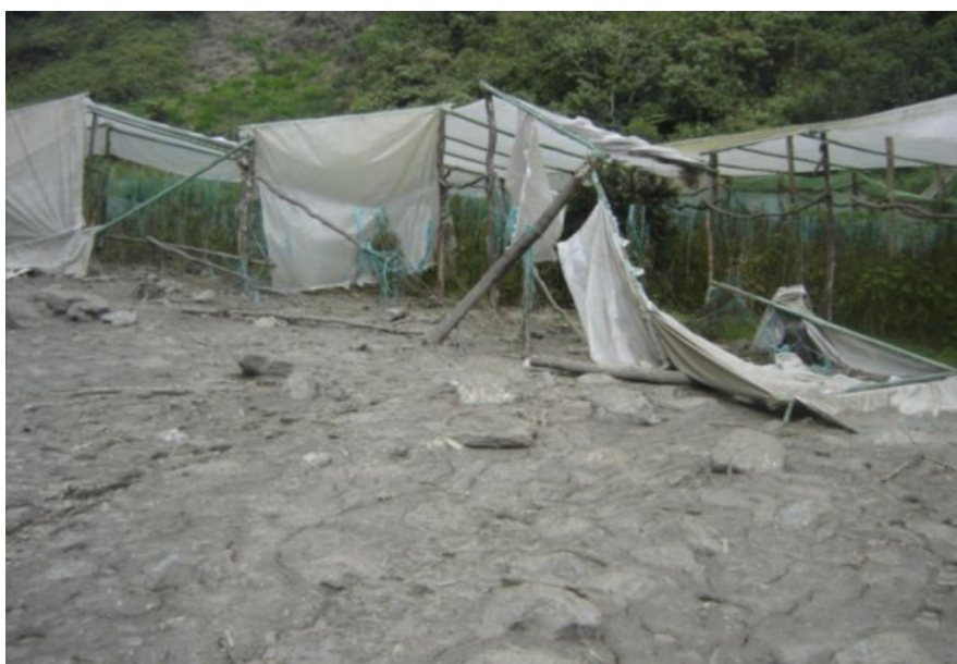
Fotografía 7 Destrucción de hosterías, comercios y fuentes de trabajo afectados
