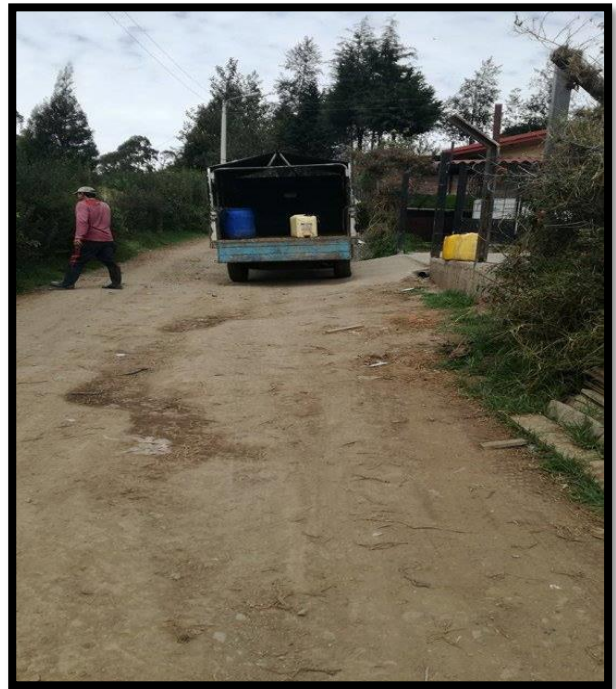
Entrada a la planta, camino de tierra
