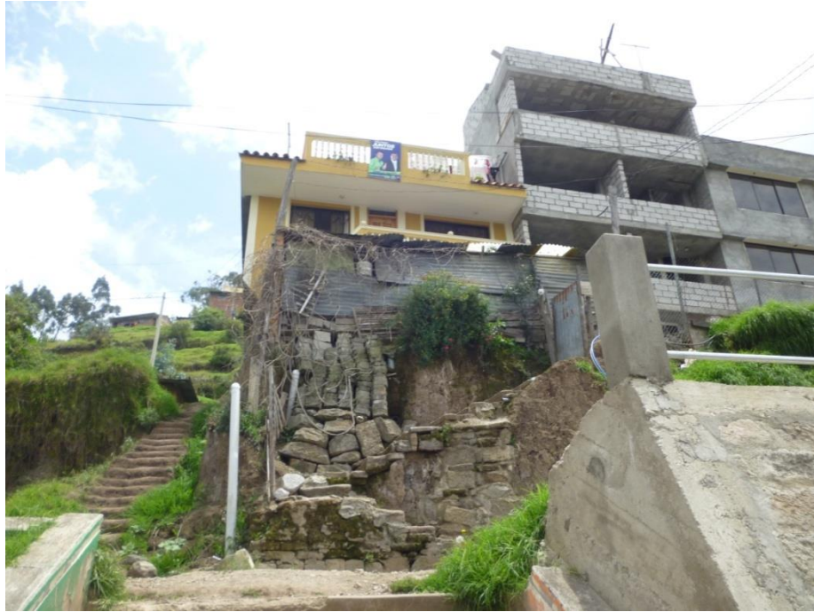
Se puede observar el riesgo que puede ocasionar esta construcción
