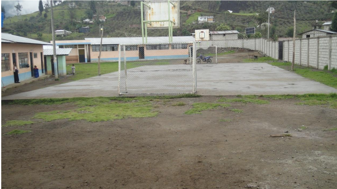
Fotografía No 1.- Fachada frontal del Centro Educativo Comunitario Intercultural Bilingüe “Nueva Esperanza
