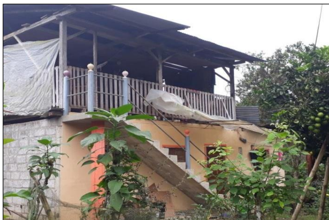
Foto 2. Viviendas construidas con madera y hormigón
