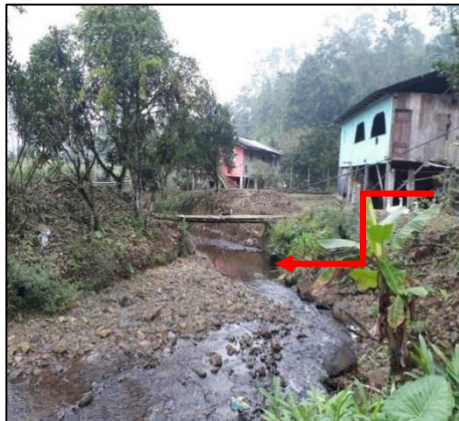
Foto 14. Se observa socavamiento en las riveras de los esteros y arrastre de materiales por crecidas.
