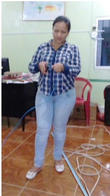
Ponchando el cable par trenzado
