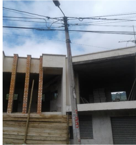
Foto 19 Sistema electrico de la Parroquia.
