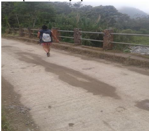
Foto 22 Puente la Plancha de hormigón sobre el Rio Cristal, permite la movilidad en tiempo normal, y la evacuación en tiempo de emergencia.
