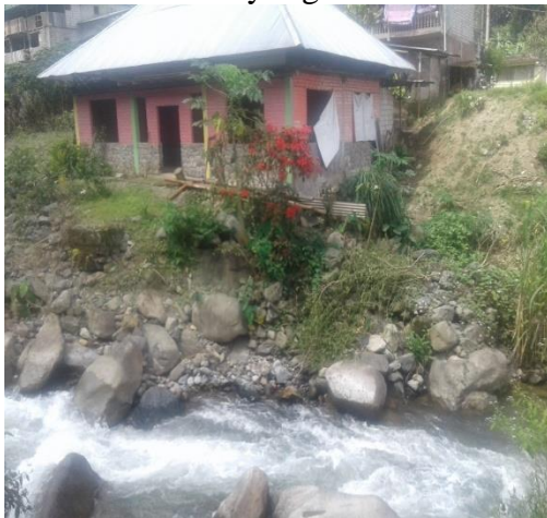
Foto 32 Infraestructura en las riberas del Rio Cristal expuesta ha la ameneza de inundación.
