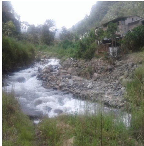
Foto 33 Infraestructuras en las riberas del Rio Cristal expuesta ha la ameneza de inundación.
