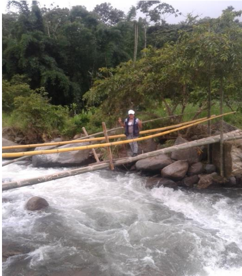
Foto 24 Puente de cana Complejo el Cristal sobre el Rio Cristal.
