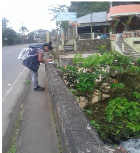
Foto 23 Coordenada del Puente la Cascada Milagrosa de Hormigon.
