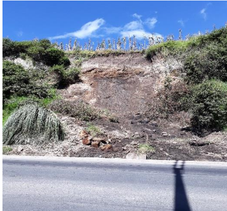
Deslizamiento sector Las Palmas
