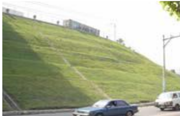
Imagen 2.13. Estabilización utilizando capas vegetales
