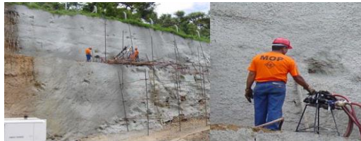
Imagen 2.11. Revestimiento de talud con concreto lanzado
