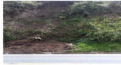
Foto 4.5. Deslizamiento en el sector de El Tejar. Fuente: Barragán e Hinojoza, 2017.
