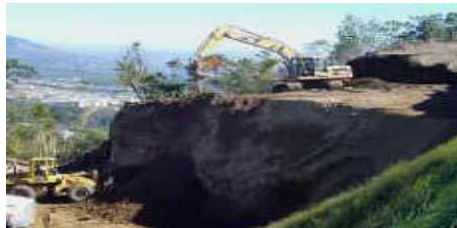
Foto 2.2. Proceso de abatimiento de talud de corte
