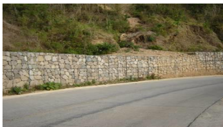
Imagen 2.20. Ejemplo muro de gavio colocado al costado de una vía
