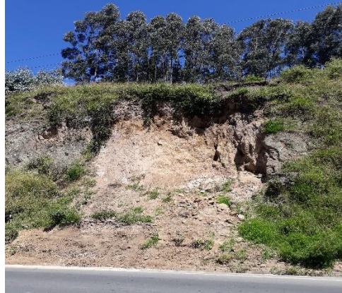
Deslizamiento sector “Gasolinera Laurita”
