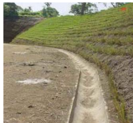
Imagen 2.6. Contracuneta en base de talud
