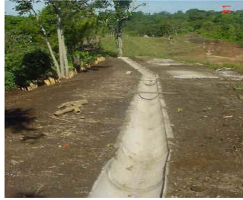
Imagen 2.5. Cuneta en la corona de un talud utilizan elementos prefabricados de concreto
