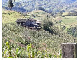
Foto 4.7. Edificación nivel de vulnerabilidad medio
