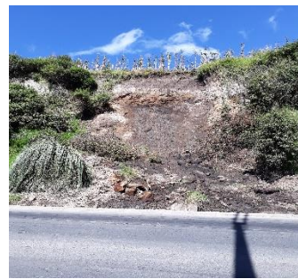
Foto 4.10. Deslizamiento en el sector de Las Palmas.
