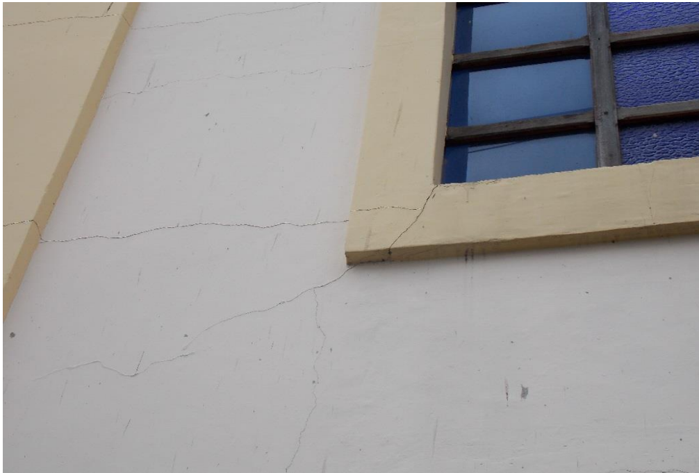
Fotografía 4 Síntomas presentes en la estructura Fuente: Recorrido de observación, fisura externa. Elaboración: Mendoza y Guaranda. 15-04-2017
