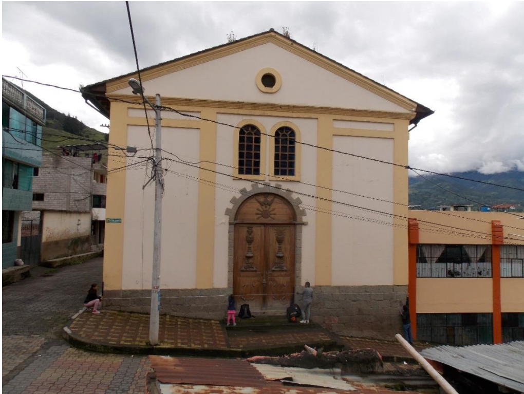
Fotografía 1: Vista general de la iglesia San Francisco
