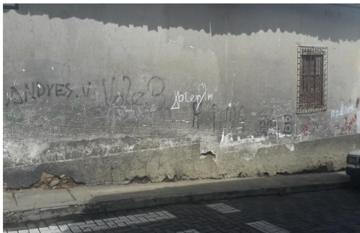
Foto 3.- Hollín impregnado en las paredes por la emisión de monóxido de carbono
