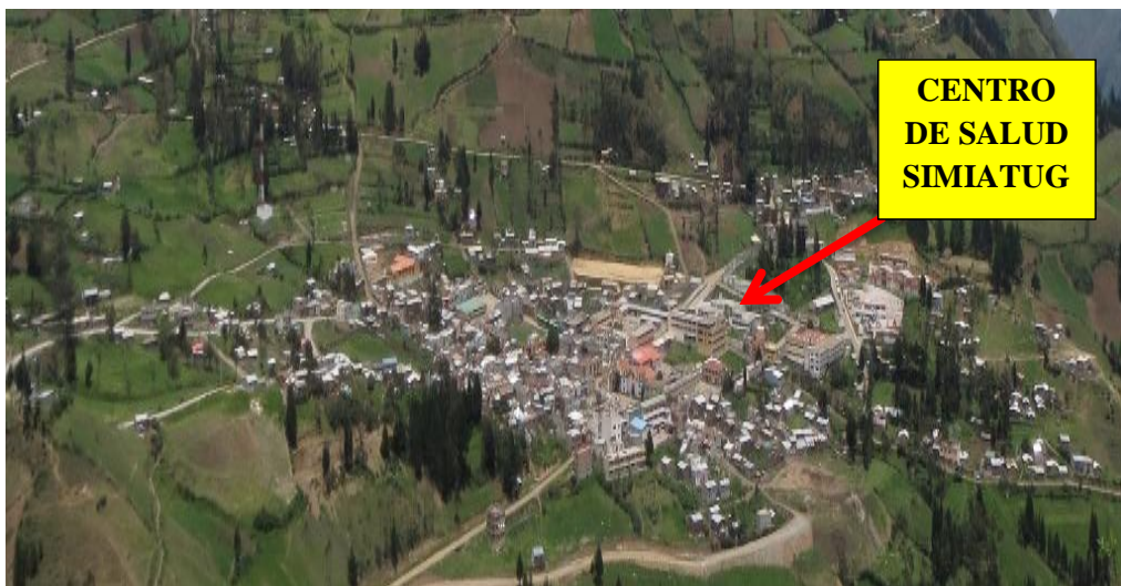
Fig. 1 TOMA FOTOGRAFICA AEREO DEL CENTRO DE SALUD URBANO DE SIMIATUG
